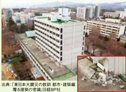
鉄骨ブレース・壁増厚・柱鉄板巻き補強校舎
