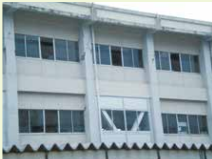
鉄骨ブレース補強校舎
