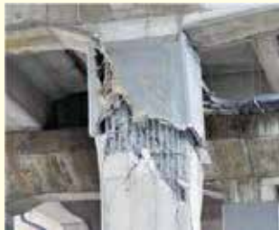
アラミドの被災事例
